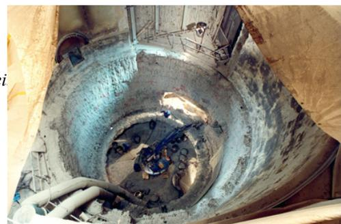
Abb.25: Biologisches Schild (beim Abbau einer Anlage)
